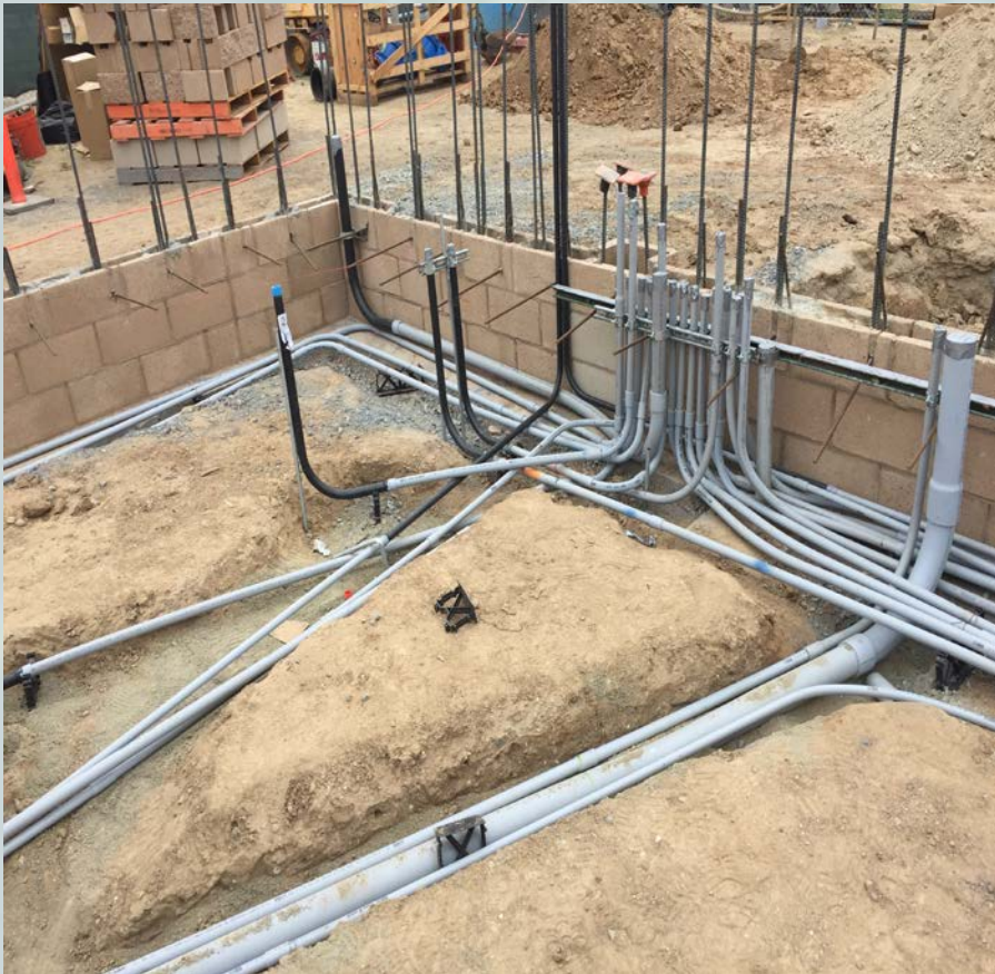
CONDUIT INSTALLATION
